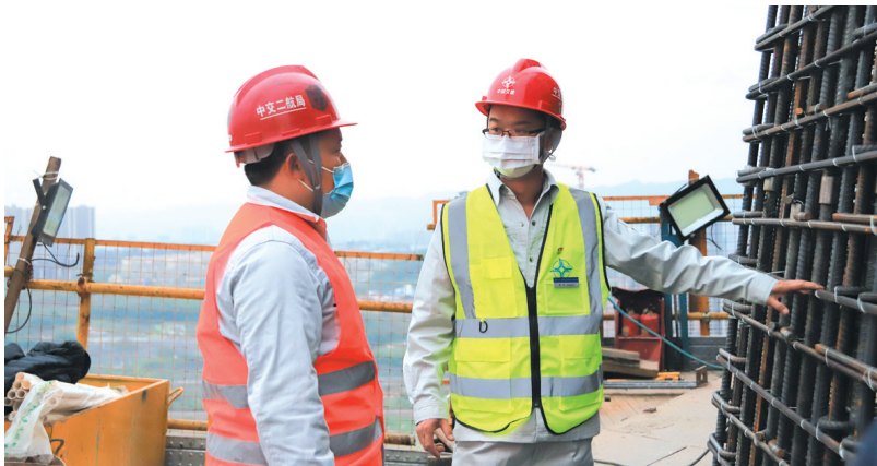
李杰(右)在施工现场了解复工情况
