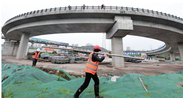
施工中的重点项目金家湾立交 摄/龙在全
