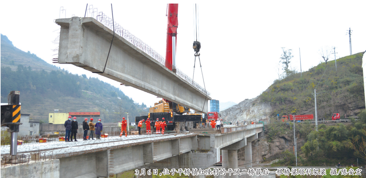
3月6日,位于平桥镇红隆村的平凤二桥最后一根桥梁顺利架梁 摄/陈会会
