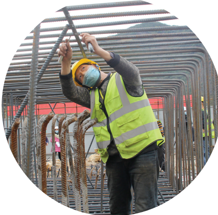
白马航电枢纽工程14#场内公路项目复工复产 摄/徐爱荣
