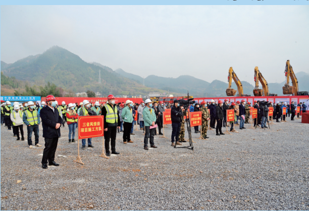
秀山县洪安镇三省风情街项目施工现场
