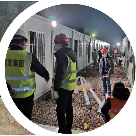
三峡担保在保客户黄梅县城发集团建设湖北省黄梅县人民医院雷山应急病区现场
