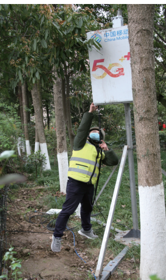
建设人员在疫情防控定点医院架设5G基站
