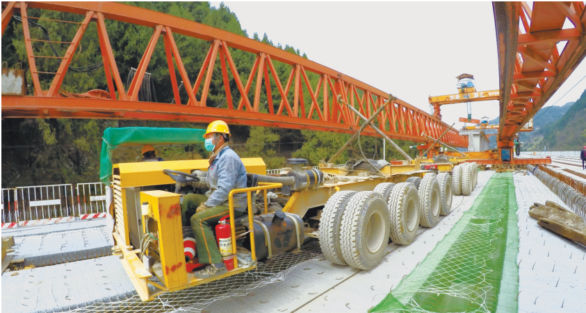
城(口)开(州)高速公路南长沟特大桥建设工地。 摄/吴廷贵
