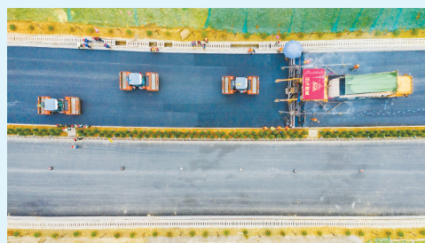
2月29日,南两高速南川段工作人员正在铺设沥青 摄/任前蔚
