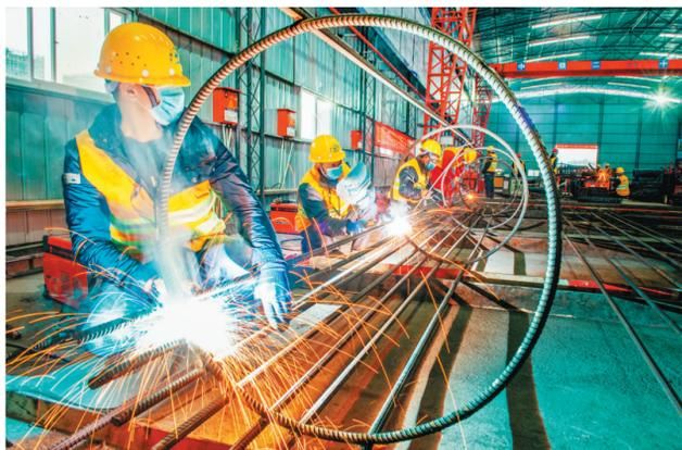
2月26日,两江新区金星节点改造工程现场,工人们在施工现场焊接钢筋。
