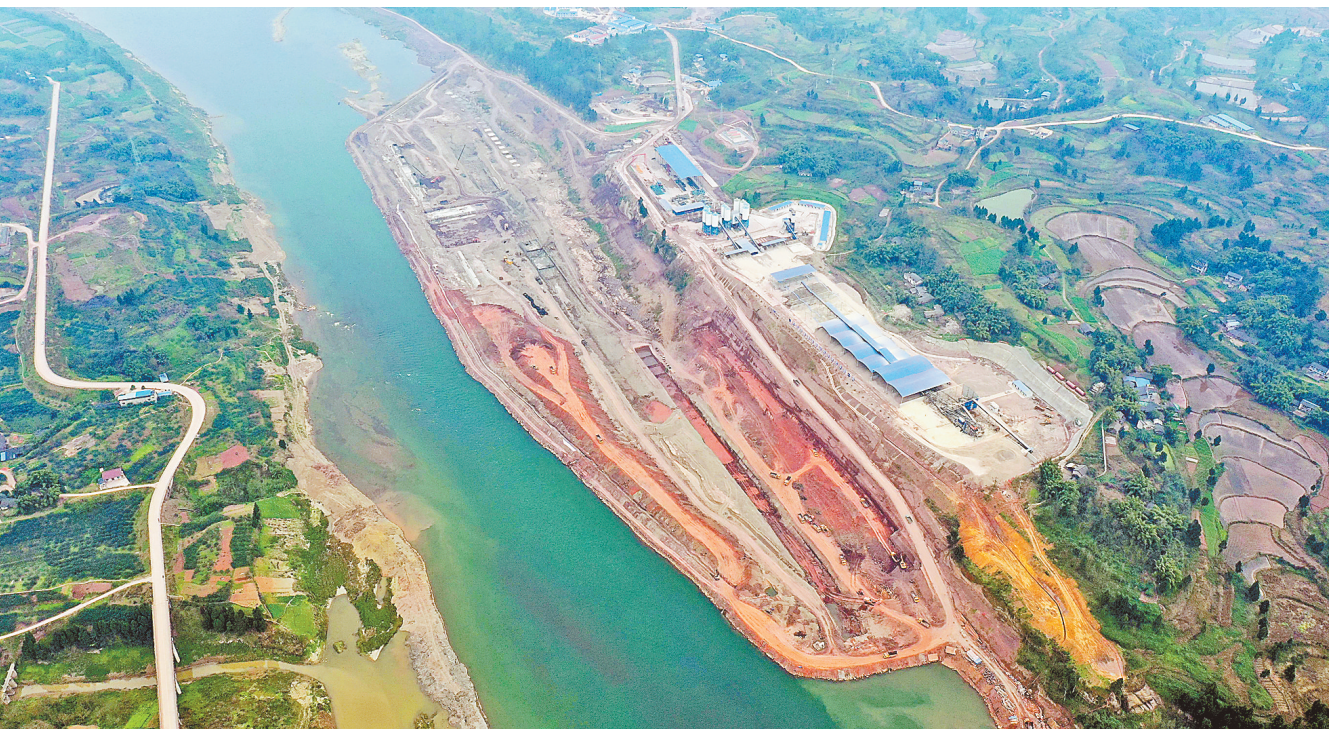
二月十四日，建设中的利泽航运枢纽工地。
