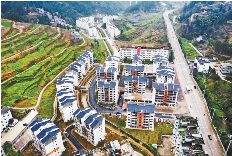
无人机拍摄的李家溪易地扶贫搬迁安置点。
