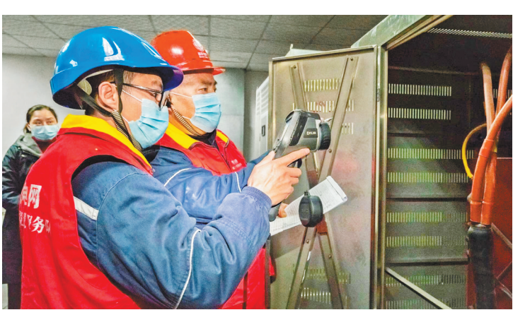
1月28日,巫山供电公司红岩共产党员服务队工作人员在当地医院对供电设施进行测温检查。
