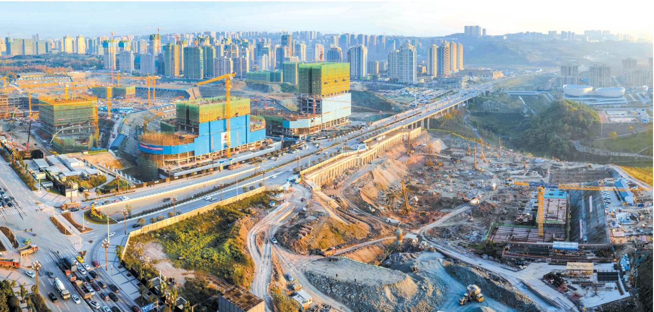
空港新城在建工地 摄/周钰莹
