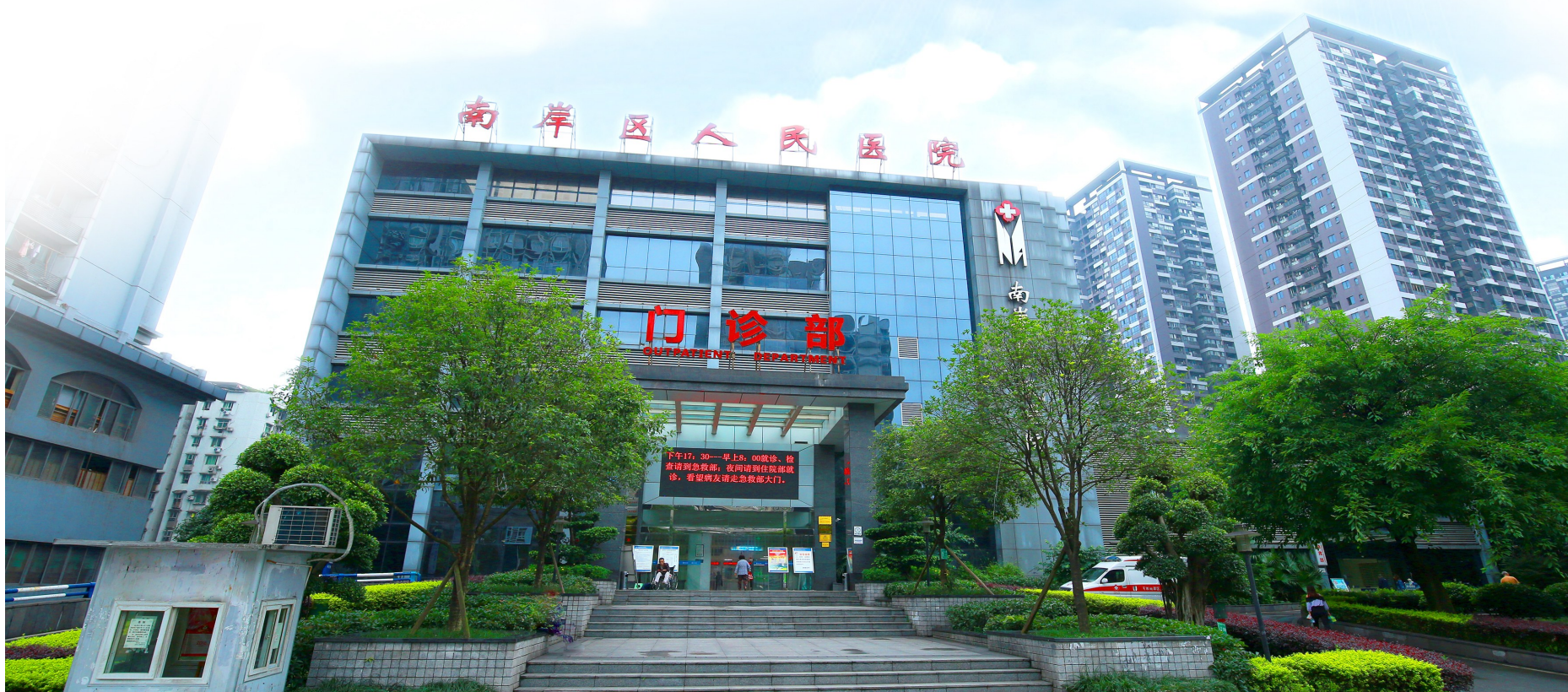
南岸区人民医院大楼
