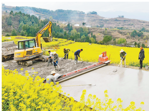
丰都县三建乡夜力坪村产业扶贫示范基地，工人在硬化社道公路。2018年，全村50余户村民以土地入股，发展西瓜、南瓜、萝卜、油菜等周期短、见效快、风险小的产业项目，确保稳定增收。（本报资料图片） 通讯员 熊波 摄
