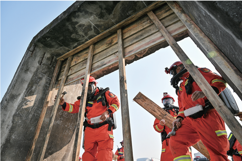
矿山及有限空间救援训练中，队员快速搭建板密壁 摄/张春晓
