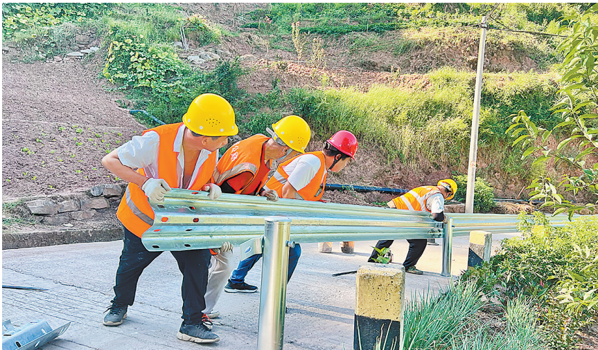
綦江区三江街道双福村，工作人员正在安装道路防护栏。（市交通运输委供图）
