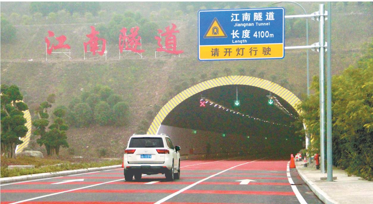
十二月一日，市重点工程江南隧道主线建成通车。特约摄影 郭旭视觉重庆
