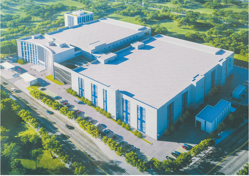
进出口银行重庆分行助力信质集团重庆工厂年产300万台新能源汽车定转子总成建设项目竣工投产 张锦辉 摄/视觉重庆
