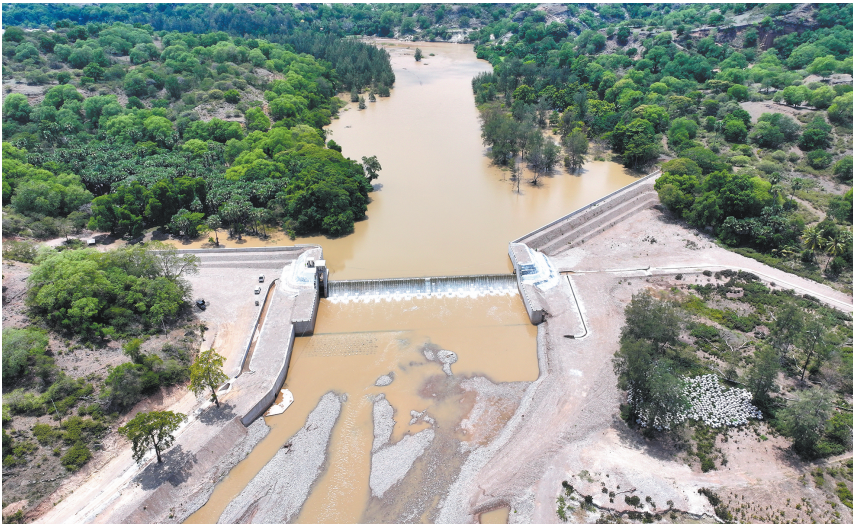
东帝汶莱维农业灌溉项目如期竣工并通过验收。(受访者供图)
