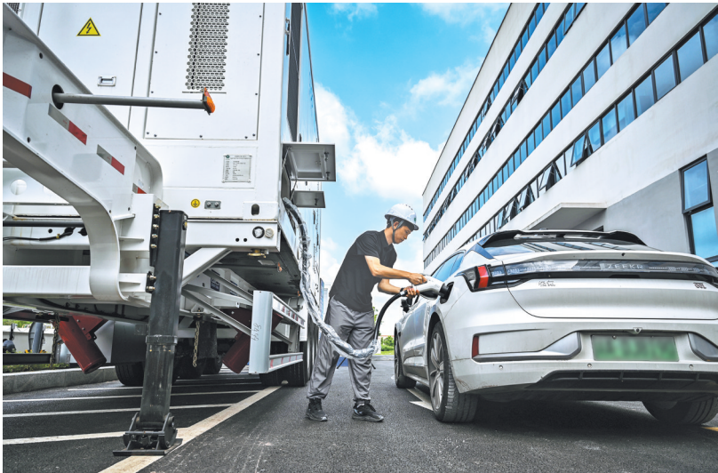
重庆高新区清安能源智慧零碳产业园区，工作人员在演示用交直流一体化充放电移动储能系统给新能源车充电。（资料图片）
