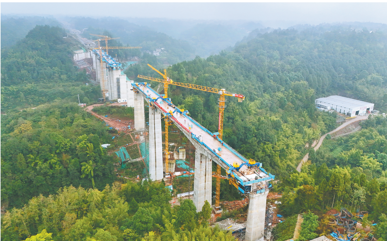
11月4日，成渝中线高铁重庆段的全线控制性工程——一碗水双线特大桥连续梁顺利合龙。（受访单位供图）
