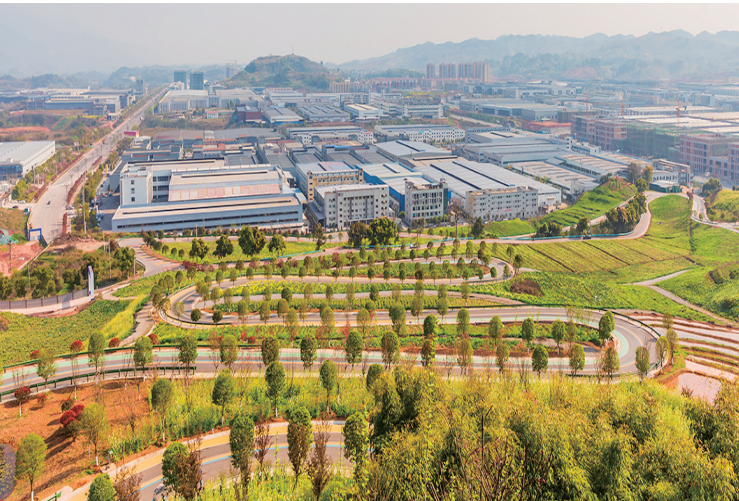
在中行金融力量支持下，蓬勃建设中的川渝高竹新区 肖先荣 摄/视觉重庆
