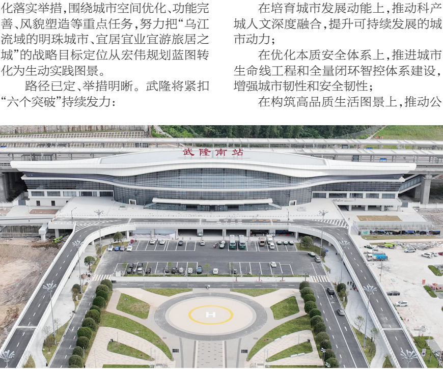
渝厦高铁武隆南站
