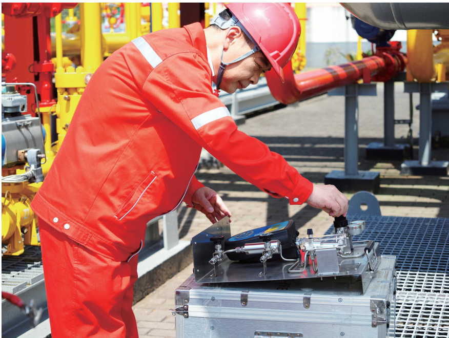
刘辉在永川作业区黄202脱水站检测天然气水露点
