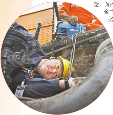
9月25日,大渡口区铜花路,燃气公司抢险人员刘瀚林在作业坑里检查焊口焊接质量。 记者 张锦辉 摄/视觉重庆
