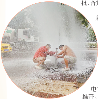
9月17日,九龙坡区锦龙路突发消火栓爆裂漏水事件,抢险人员在进行带水抢修。 (受访者供图)
