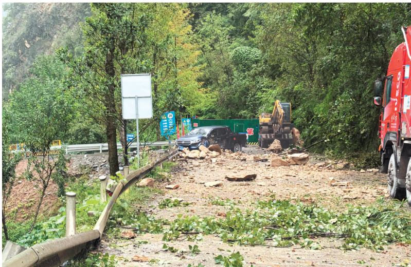
十月四日，来源于虎耳岩侧面落石，造成路面严重受阻。（受访者供图）
