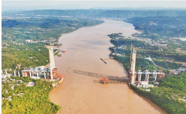
建设中的渝万高铁石沱长江大桥。(受访者供图)
