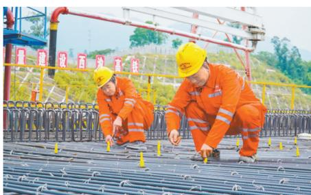
10月5日，西渝高铁合川东制梁场，工人们正绑扎预制箱梁钢筋。 通讯员 冉杰 摄/视觉重庆
