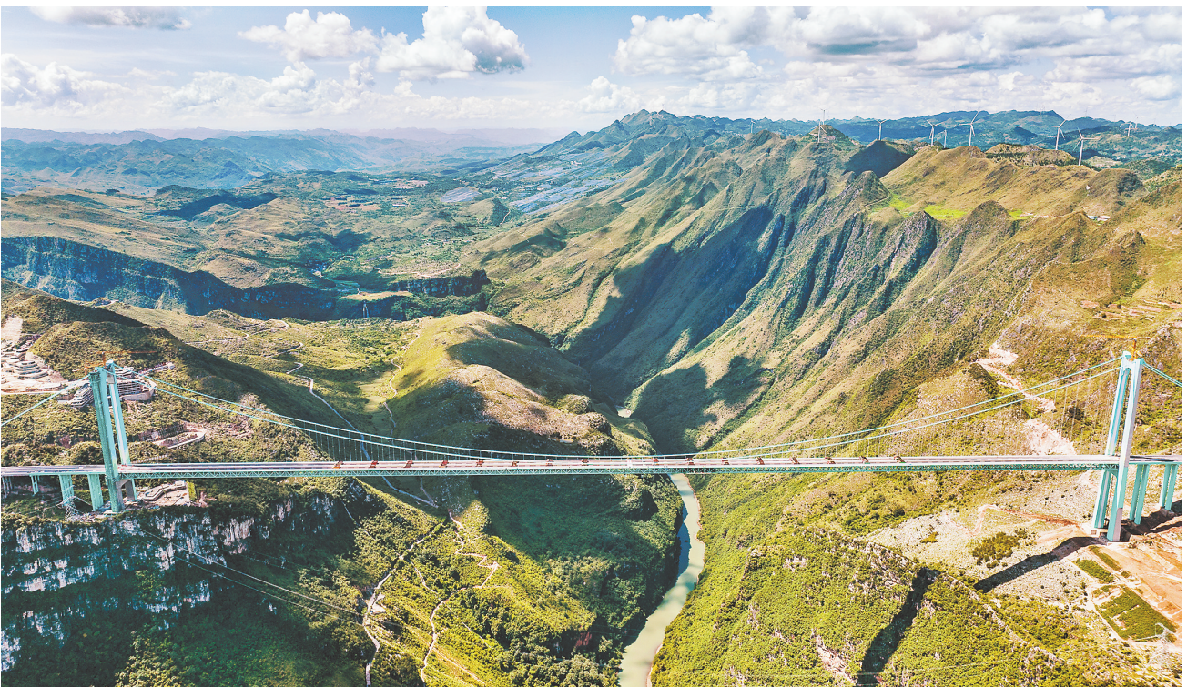
8月25日拍摄的贵州花江峡谷大桥荷载试验现场(无人机照片)。
