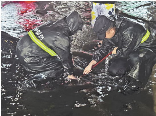
►九月十二日，渝中区曾家岩轨道交通站外，群防人员在积水中进行清掏作业。（受访者供图）
