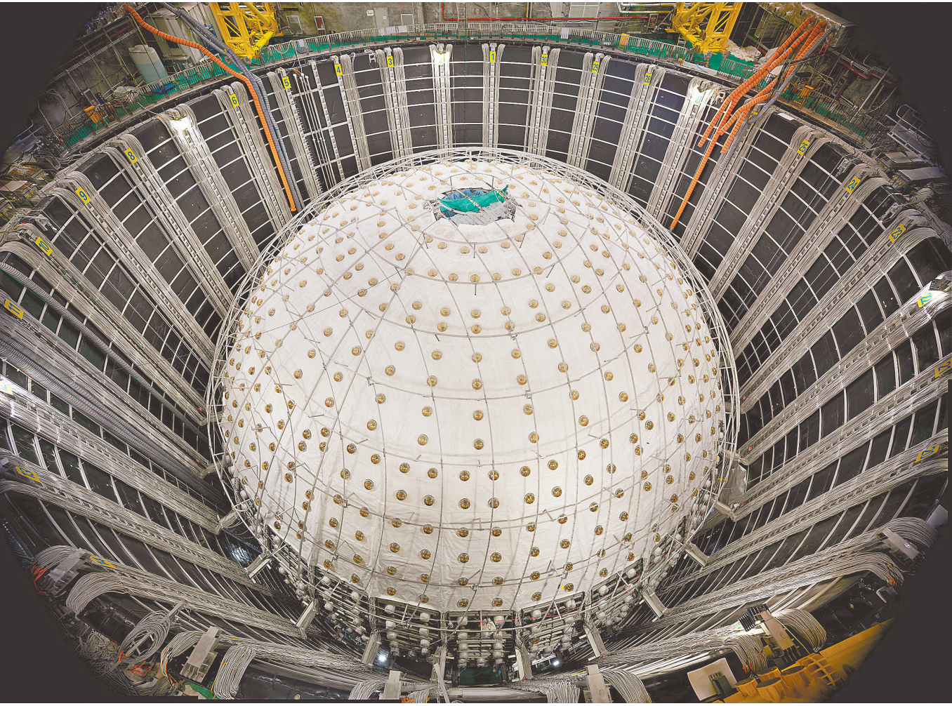
建设中的江门中微子实验中心探测器(拼接照片,二〇二四年十月九日摄)。新华社记者 金立旺 摄
