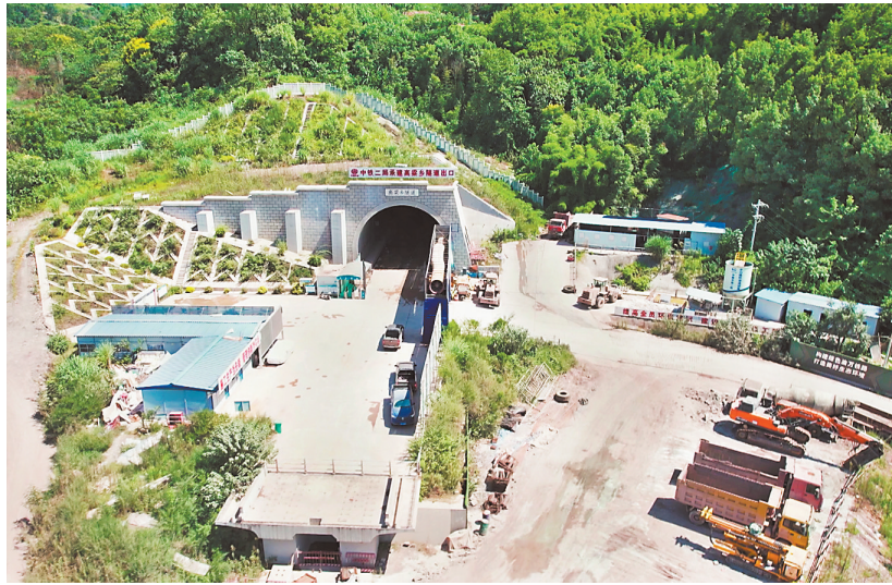
8月26日贯通的新渝万高铁万州枢纽项目高粱乡隧道。（受访者供图）
