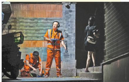
8月15日，渝中区七星岗兴隆街，自来水公司管网巡线人员头戴耳机，手持听漏仪、听漏杆开展地下供水管道听漏工作。（本版图片均由记者张锦辉摄/视觉重庆）
