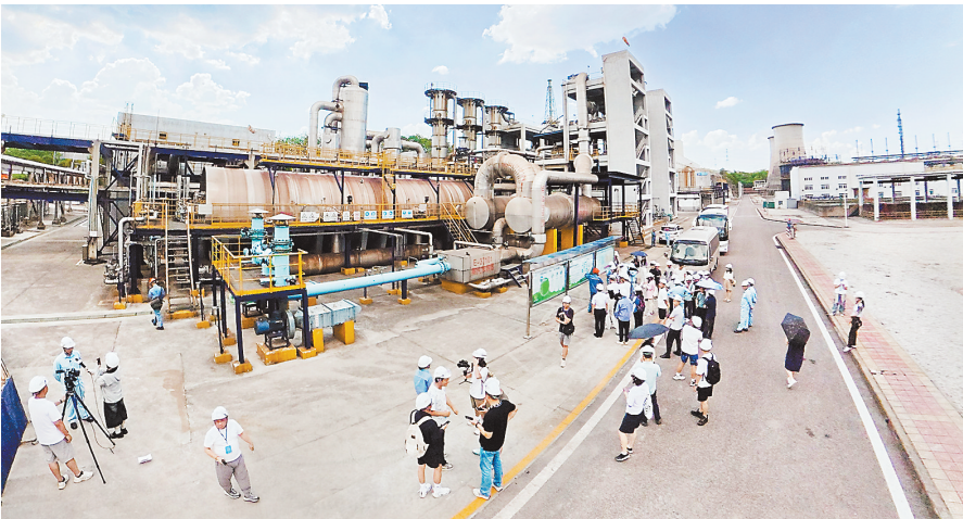
8月14日,记者团走进川维化工考察调研废硫酸再生利用装置。记者 李雨恒 摄/视觉重庆
