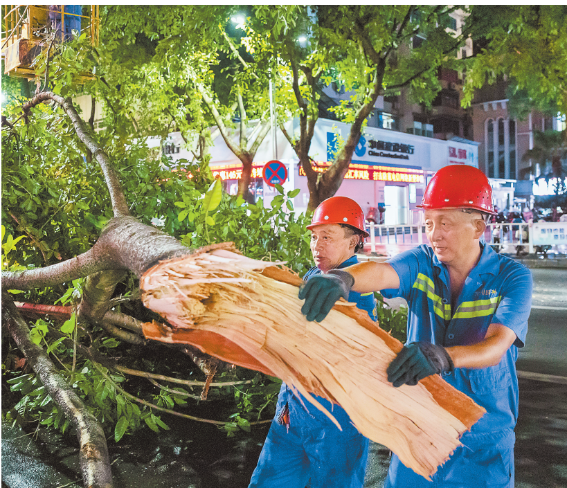
▲8月10日傍晚,南川区南大街南大桥路段,区城市管理局园林绿化工人正忙着清理倒伏树枝,确保道路畅通与市民安全。
