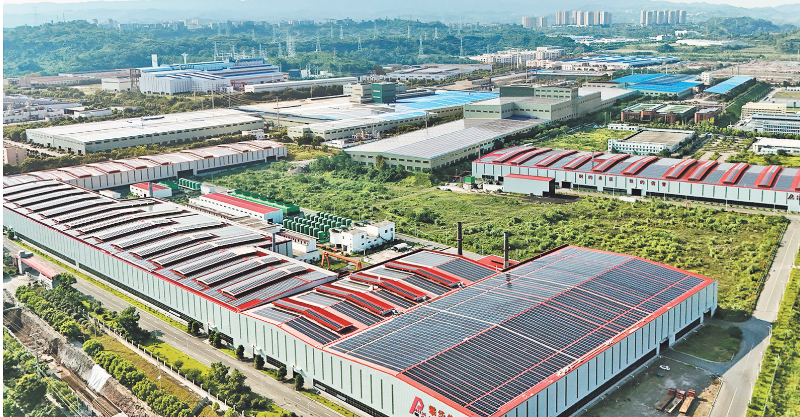
涪陵攀华集团屋顶光伏项目。
