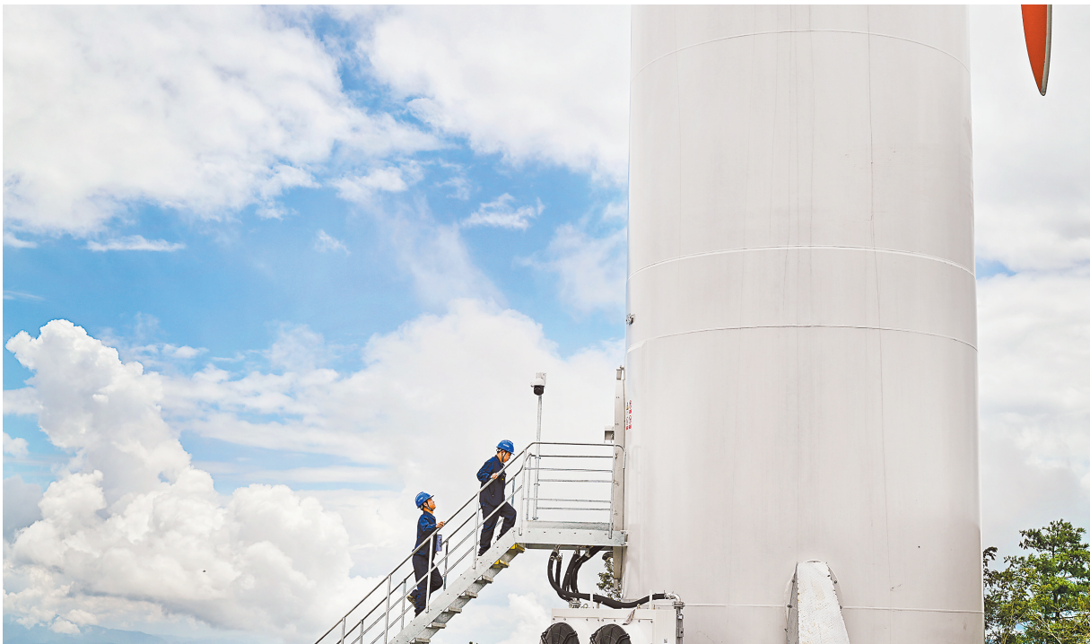
七月二十四日,巫山县三溪乡六号风机电塔筒,工作人员在进行巡检。
