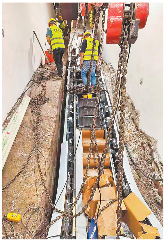
工人在进行扶梯施工。
