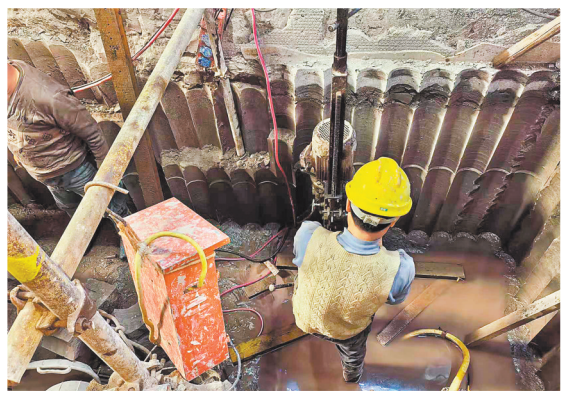
工人在坚硬的岩石上开凿电梯基座。
