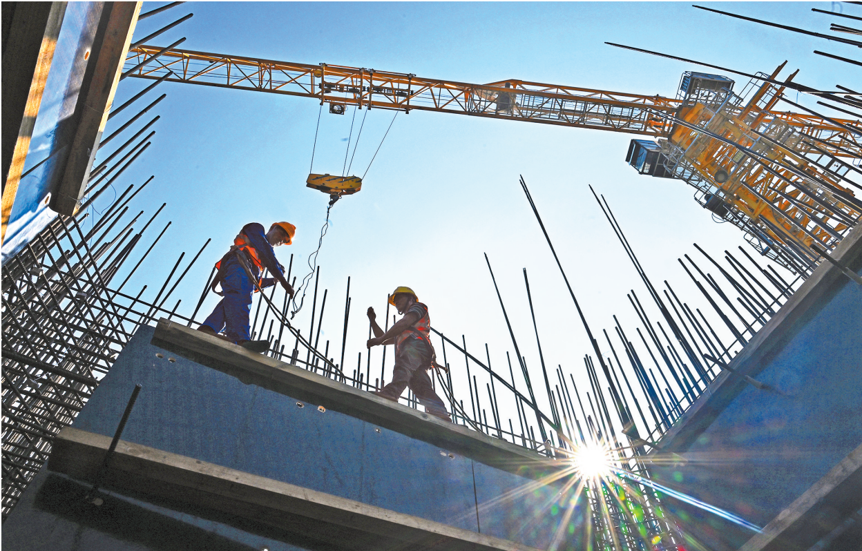
七月十五日上午九点，西渝高铁控制性工程——北碚天府嘉陵江特大桥施工现场，中铁十一局的建设者们正在进行桥梁上部结构施工。 记者 罗斌 摄视觉重庆
