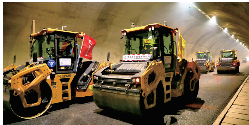
重庆高速巨能集团成功实现山区特长隧道无人摊压施工,图为正在隧道施工的无人摊压机 摄/杨勇
