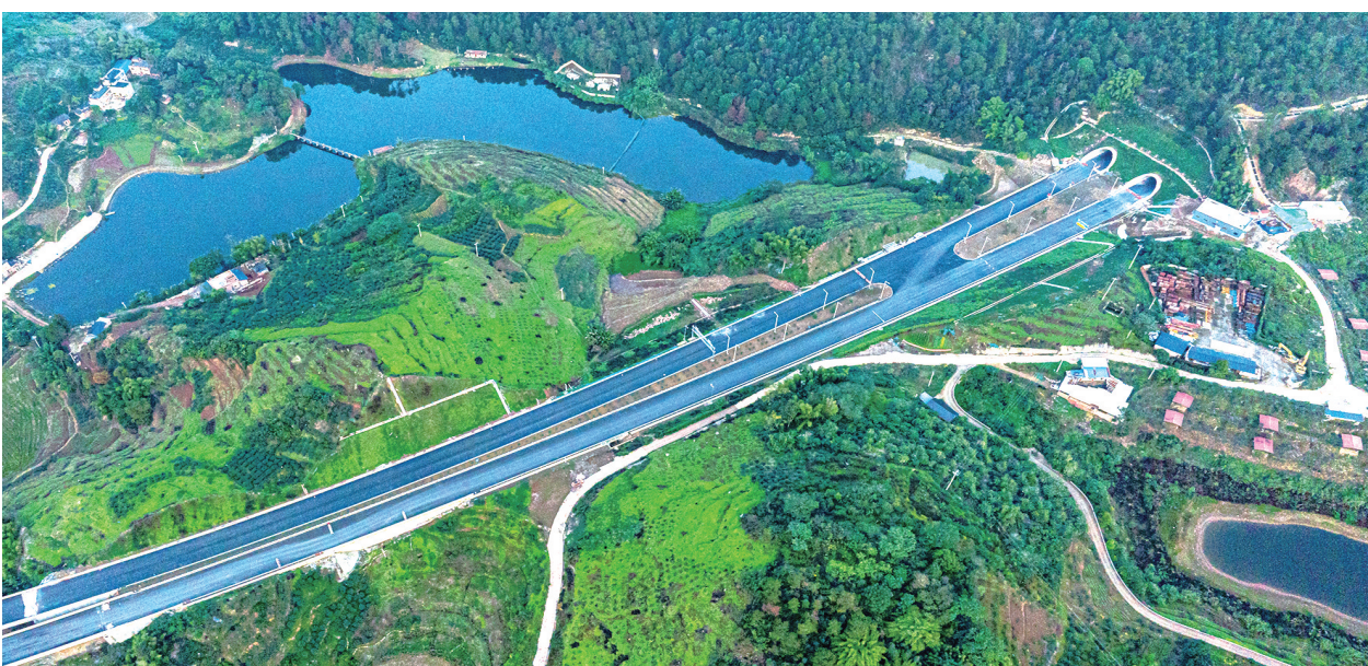
巨能集团承建的永津项目云雾山隧道进口端 摄/胡天庆
