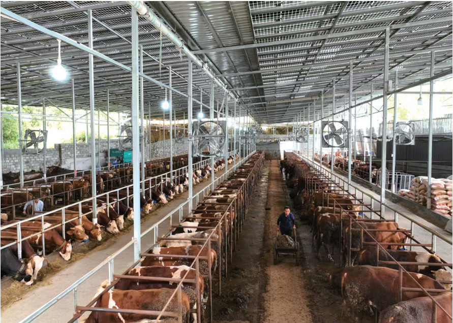
黔江区白土镇鞍山村光伏养牛场
