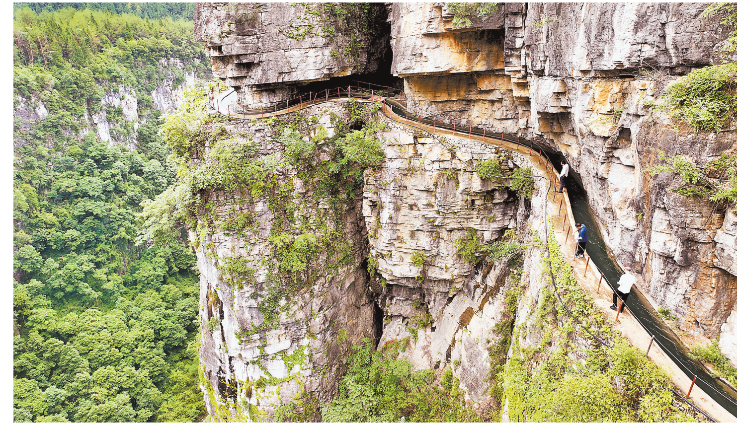
扯情岩挂壁水渠嵌在绝壁之中。行走在渠边缘,村民当年用钢钎和铁锤在岩石上一寸寸凿出的痕迹仍清晰可见。通讯员 罗治洪 摄视觉重庆
