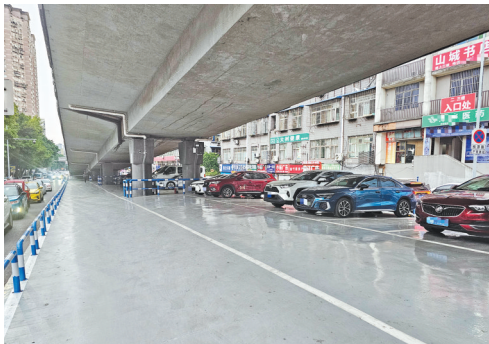
重庆市第六人民医院附近的桥下空间,投用的小微停车场缓解了就医停车难。(南岸区城市管理局供图)
