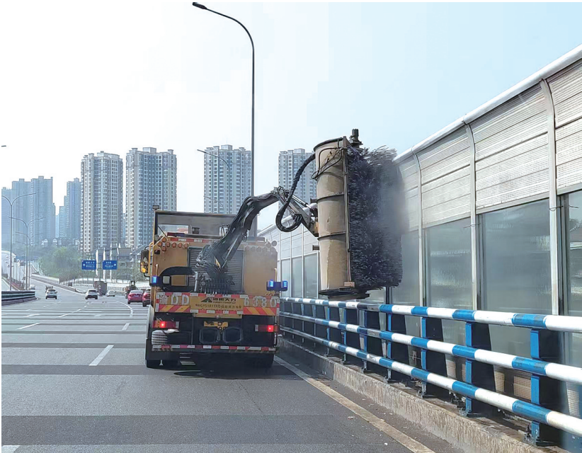
机械清洗隔音屏
