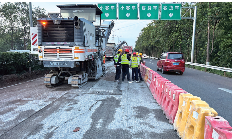
快速路综合整治施工现场
