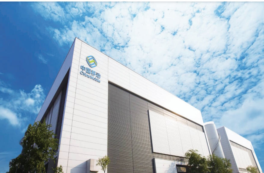
位于重庆两江新区的中国移动成渝(重庆)数据中心
