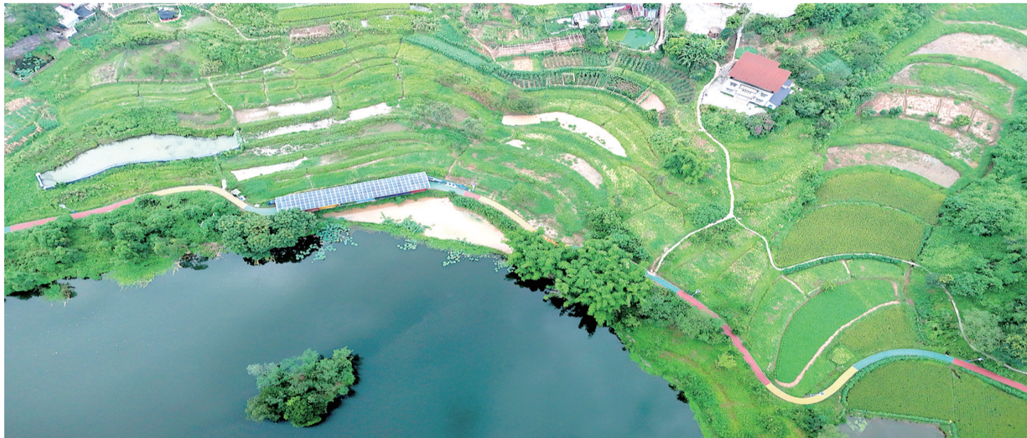
重庆高新区巴福镇钟鹤村的光伏长廊为现代农业储能供电
