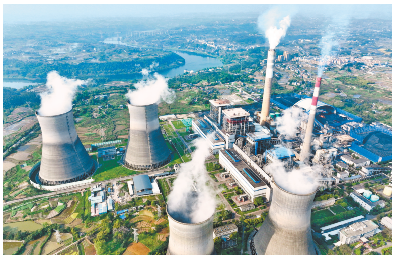
重庆合川发电有限公司双槐电厂（正在有序运转发电。摄于四月十八日） 记者 郑宇 摄视觉重庆
