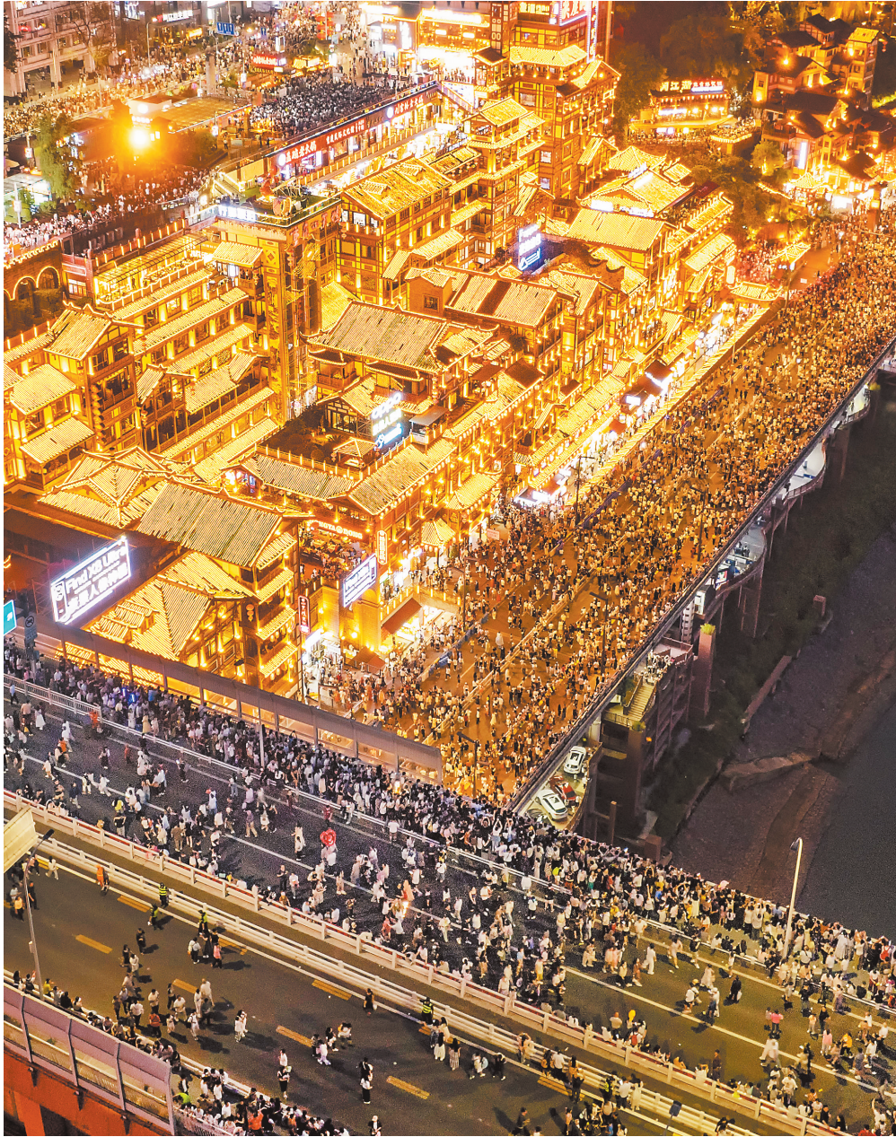
▲5月1日,渝中区洪崖洞民俗风貌区游人如织,千厮门嘉陵江大桥再次封桥让路。“五一”假期,重庆文旅市场人气十足。 记者 张锦辉 摄/视觉重庆
