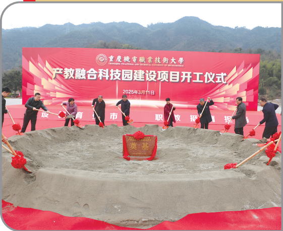
重庆机电职业技术学院产教融合科技园建设项目开工仪式
